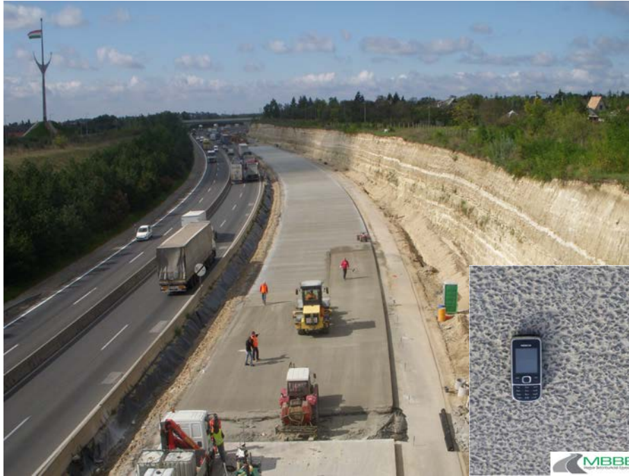
4. ábra Mosott felületű betonburkolat készítése az M0 déli szektorának autópályává bővítése során 2010-ben
