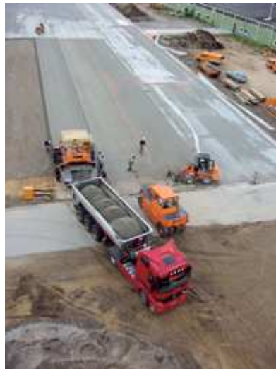
6. ábra Hengerelt beton beépítése sávokban
