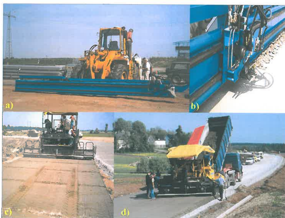
3. ábra Hézagok készítése KRAFT berendezéssel hengereltbeton alaprétegbe. a) KRAFT berendezést hordozó rakodógép. b) a KRAFT berendezés vágó-kitöltő szerszáma. c) KRAFT berendezéssel vágott hézagok okozta egyenetlenségek az aszfaltfiniszerrel elterített előtömörített hengereltbeton alaprétegen. d) Kompozit burkolat teherhordó rétegének készítése hengerelt betonból. (Könyv 10.25. ábra)
