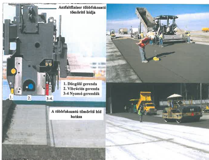
1. ábra A hengereltbeton-burkolat építés gépei. (Könyv F10.19 ábra)
