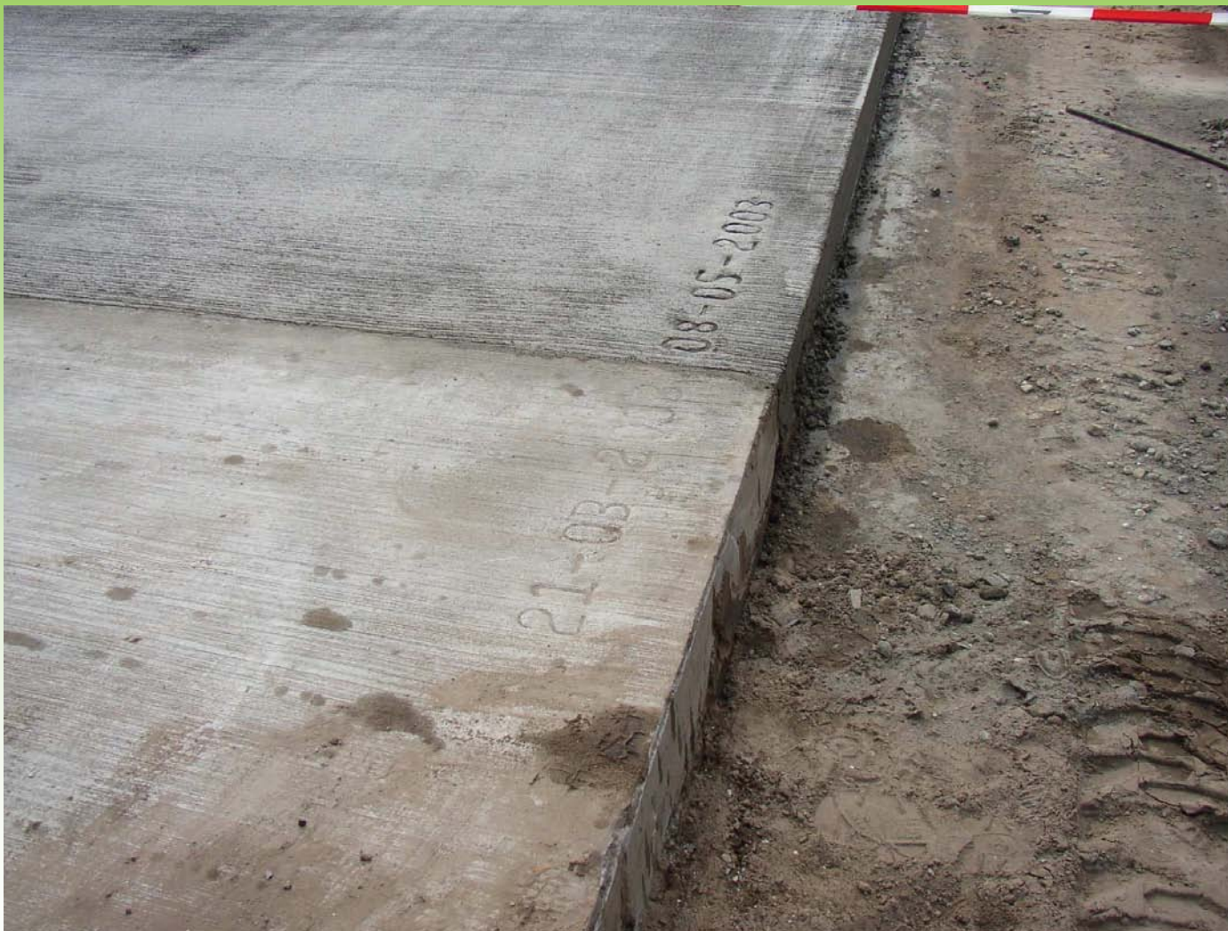
Keresztirányú munkahézag és hosszirányú szoroshézag
